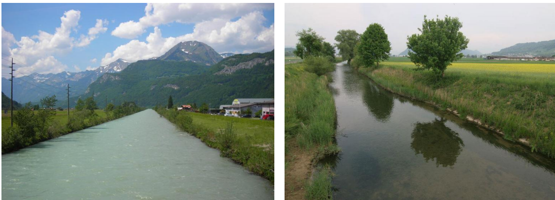
Abb. 3 Beispiele begradigter Fliessgewässer im Kanton Bern (links: Hasliaare, rechts: Gürbe)
